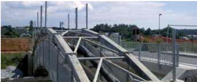
*Kabelbrücken für die Fernwärmeleitung wurden über die Umfahrungsstraße sowie vom Werk Süd in Richtung Stadt gebaut. Mit dieser Leitung kann der Bereich Preding in Zukunft mit Fernwärme erschlossen werden.*
